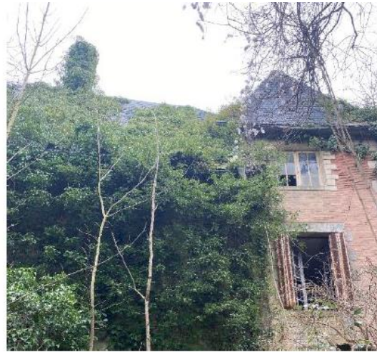
Etat existant du Château de Montjay intérieur-extérieur 2024
